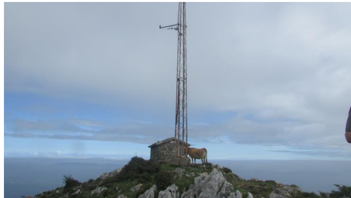
Instalación de antenas en la cota 1.123.
