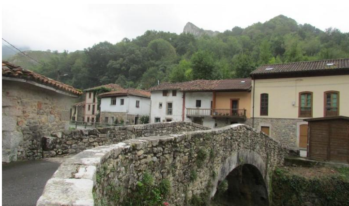
Cruce por el puente de La Riera
