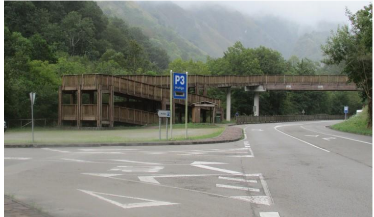
Elevado de cruce de calzada pasado Muñigo
