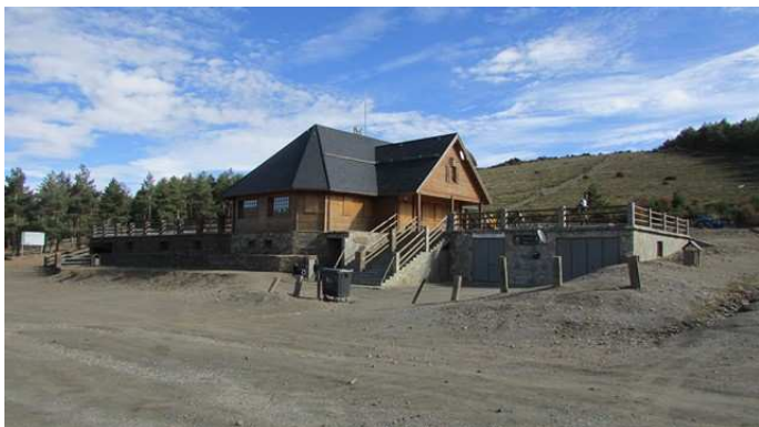
Estación Invernal del Puerto de La Ragua
