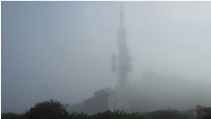
Instalación de antenas cerca del Fitu
