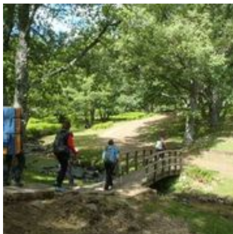
Puente del Arroyo de la Yedra
