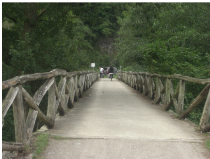
Puente sobre el Río Trubia
