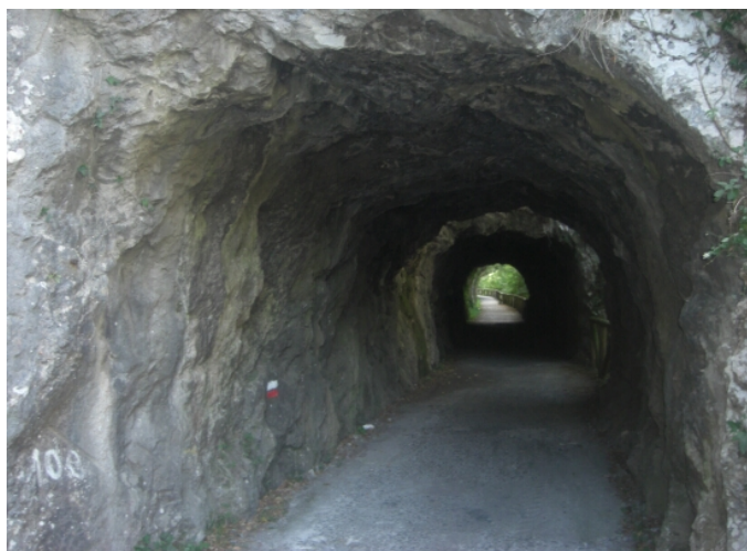
Uno de los túneles pasado Proaza al lado del Trubia
