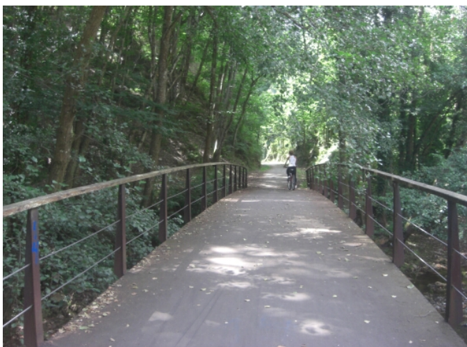
Puente Pilares, sobre el Río Teverga
