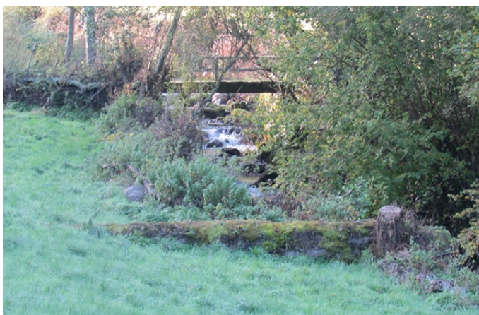
Vista del puente sobre el Río Pigüña
