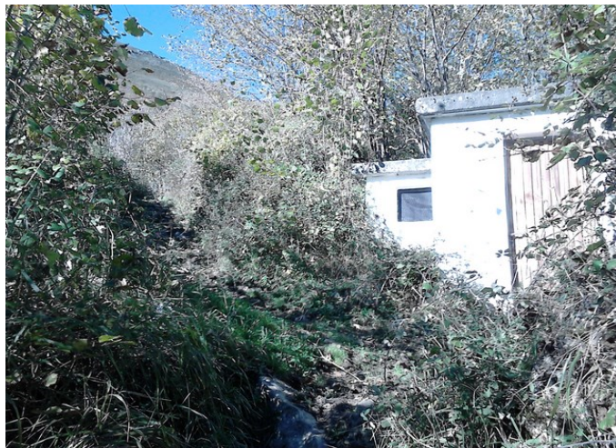
Depósito de registro de aguas
