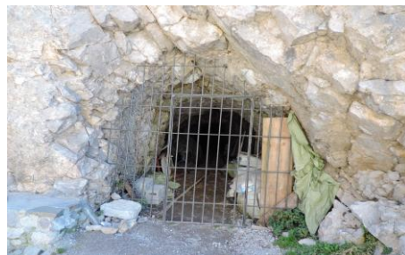
Una de las bocaminas
